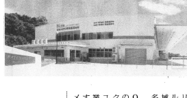
間エコテクノロジー
