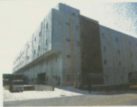
稼働を開始した第3工場
